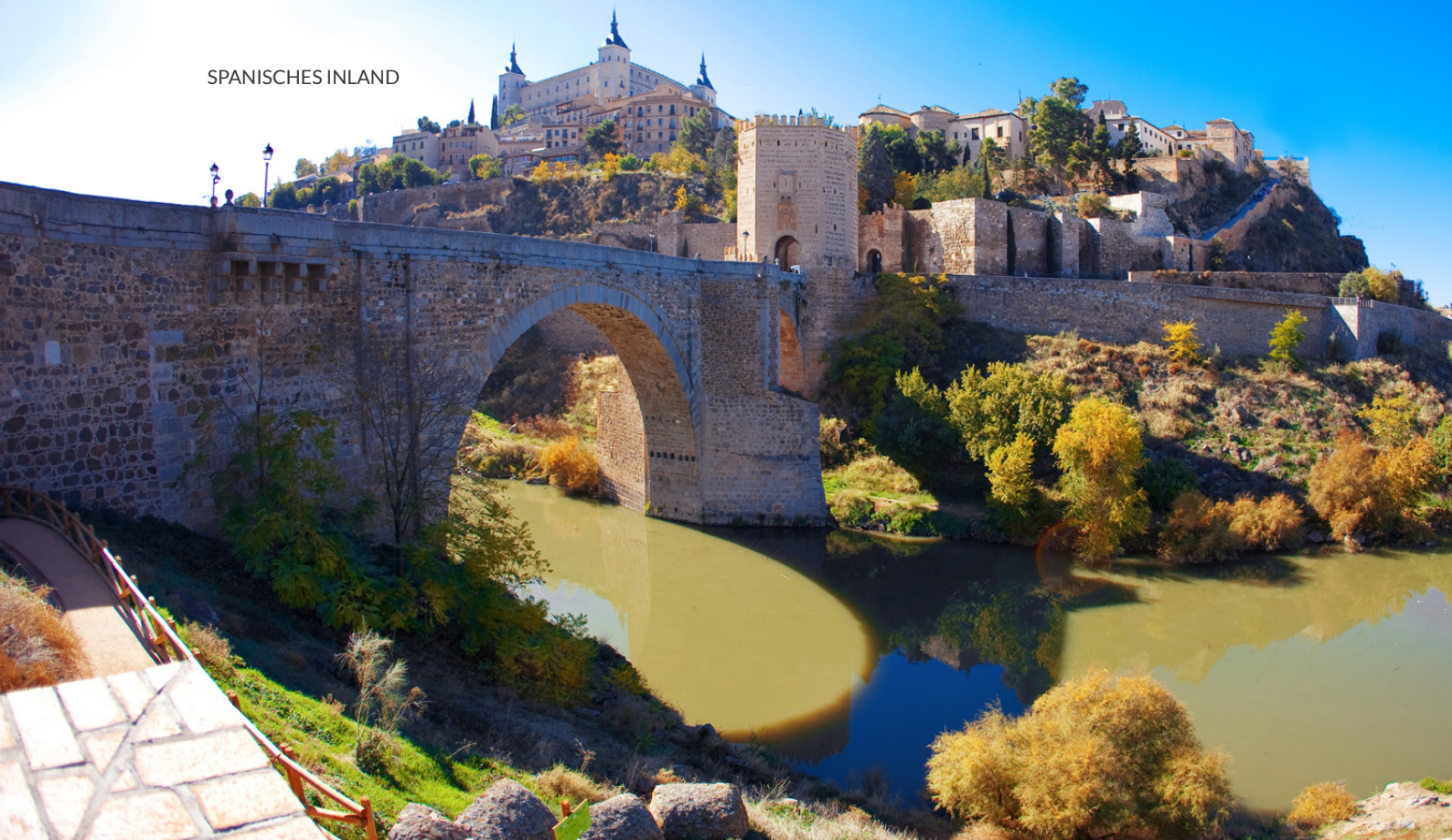
▲ BRÜCKE VON ALCÁNTARA TOLEDO
